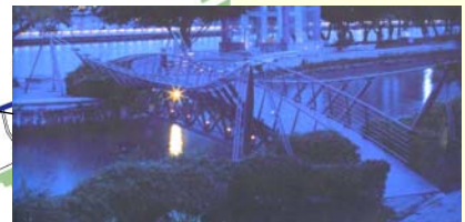
跨河橋改建整修
