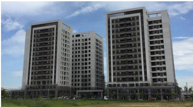
施工進度(106年8月)
